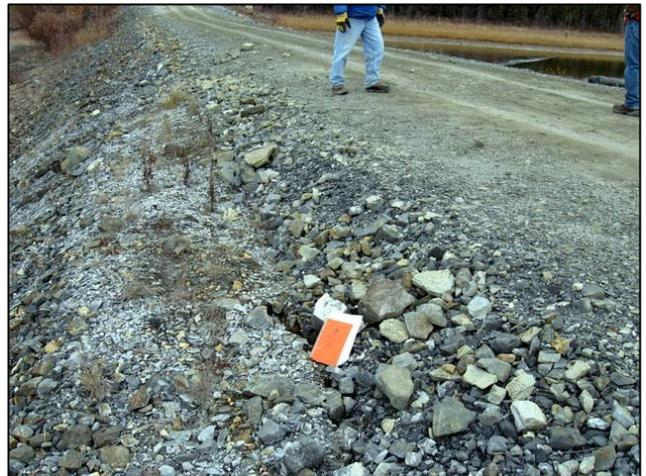
Figure 19 Longitudinal Cracking
