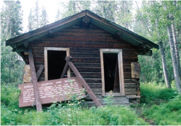
Église St. James, 2000. Le piètre état du panneau d'interprétation est la résultante du transport glaciaiel. On pense que l'action périodique des glaces flottantes aurait endommagé ou détruit quantité de structures historiques à Forty Mile.
