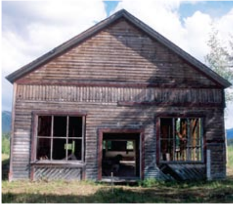
Façade ouest de l'entrepôt de l'Alaska Commercial Company à Forty Mile.
