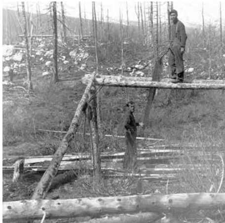
Deux hommes en train de scier des billes à la main pour la construction d'un bateau.
