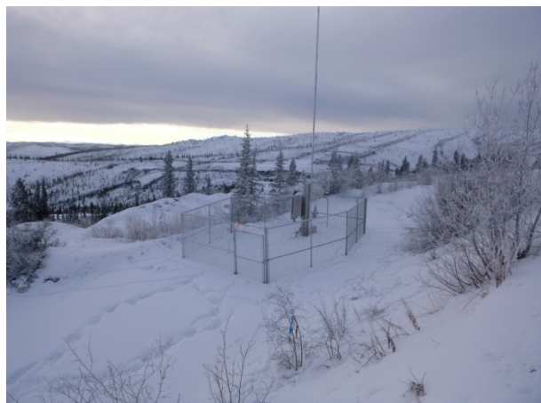
Photo 24. Met station overview.
