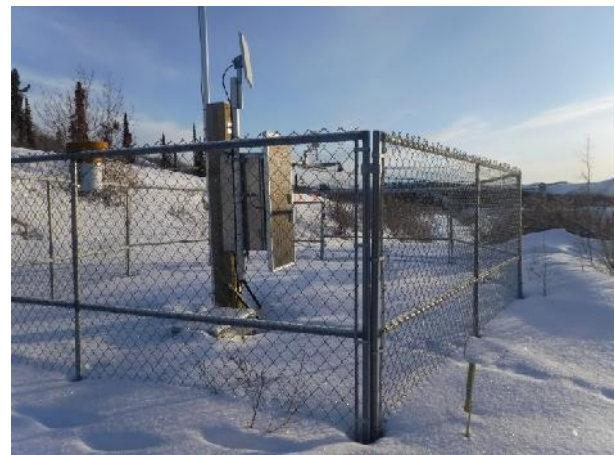
Photo 24. Met station overview.
