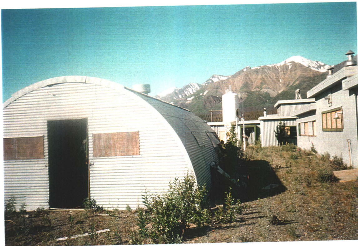
Quanset hut exterior.
