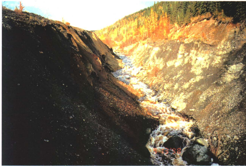
UMA Photo 7-17: Channel Erosion (1998)
