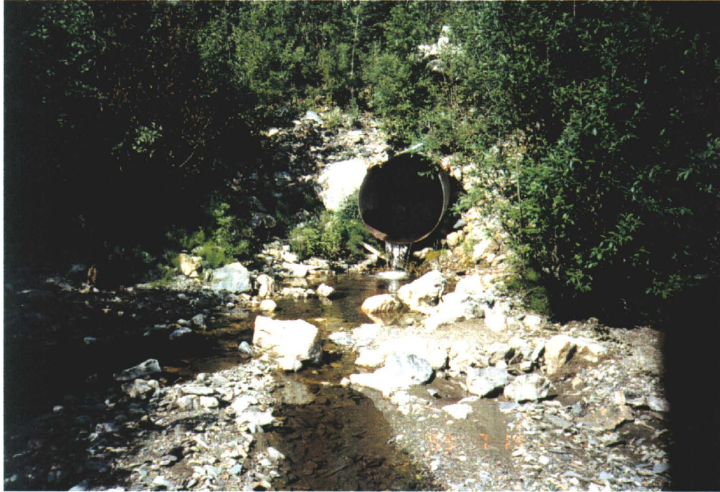
UMA Photo 15-15A Eagle Creek Culvert
