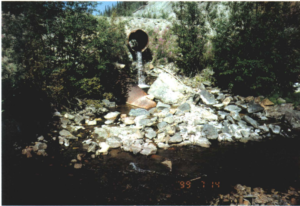
UMA Photo 15-10A Wolverine Creek Outlet Culvert
