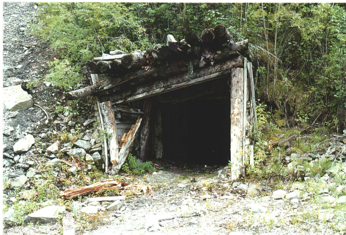
Photo 4. Paddy mine adit.
