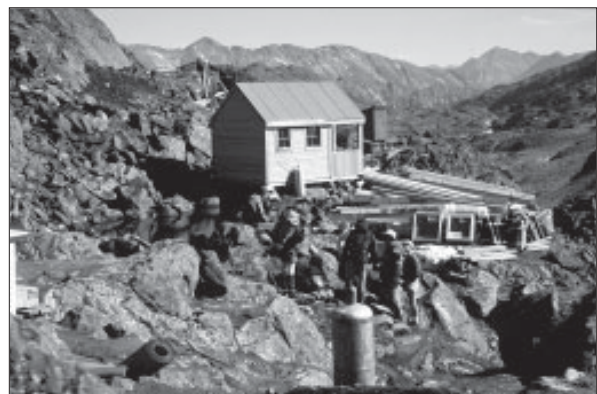
Construction d'un abri au sommet
