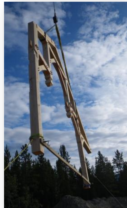
Figure 2 : Montage de la structure en bois d'œuvre
