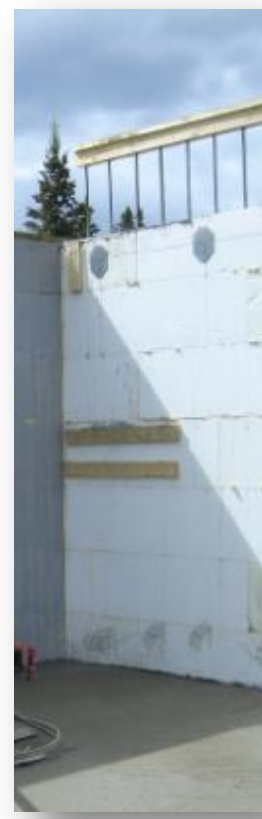
Figure 4 : Détails des coffrages isolants
