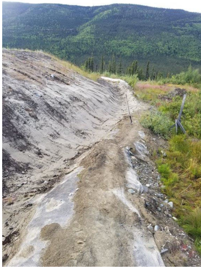
Photo 10 - DSTF Diversion Ditch (August 18/20)
