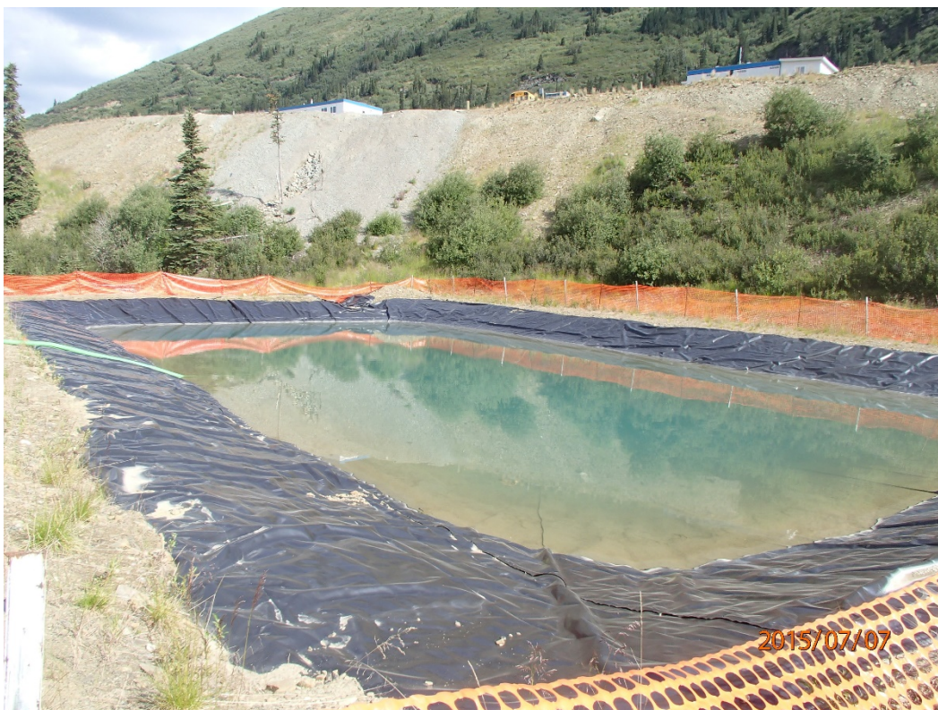
Photo 41 Sewage Effluent Pond
